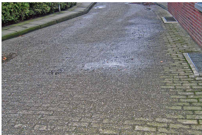
Abb. 3 a+b: Altersgemäße Menge an Betonabwitterungen an den Pflastersteinen einer alten Pflasterdecke
