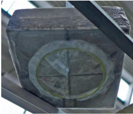
Bild 6: Penetrationsprüfung an Stahlfaserbetonen
