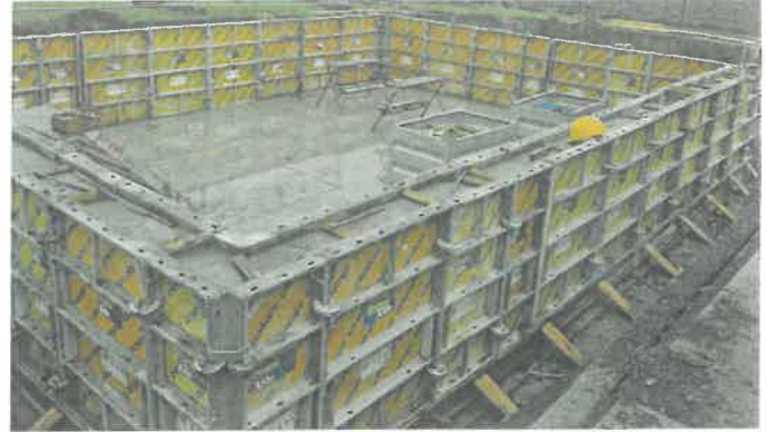
Bild 3: Nassnachbehandlung der Bodenplatte
