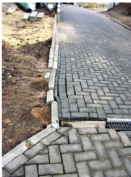
Abb. 9 a+b: Verschiebungen aufgrund nicht lagestabiler Einfassungssteine
