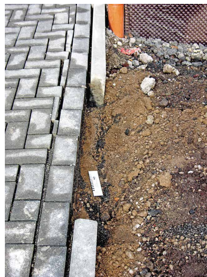
Abb. 9 a+b: Verschiebungen aufgrund nicht lagestabiler Einfassungssteine
