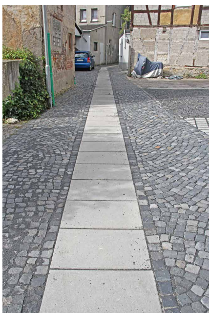
Abb. 1: Pflasterdecke mit einer mittig ausgeführten gebundenen Entwässerungsrinne, bestehend aus Betonplatten und einem Natursteinläufer
