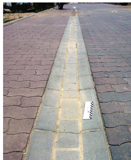
Abb. 6 a+b: Rinnenanlage mit in regelmäßigen Abständen auftretenden Rissen
