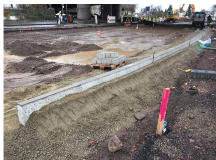
Abb. 8: Übliche Verdichtung von Rückenstützenbetonen
