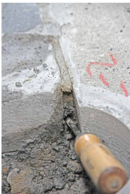
Abb. 5 a+b: Fugenfüllung zwischen den Betonplatten
