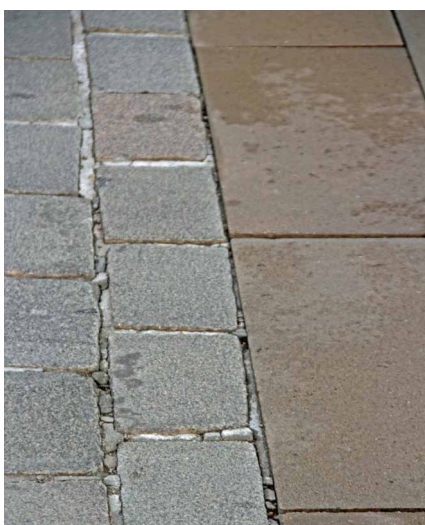
Abb. 7: Ungebundener Fußgängerüberweg über eine in vollgebundener Bauweise ausgeführte Straße
