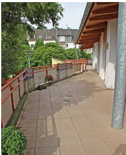
Abb. 5 a+b: In Mischbauweise mit ungebundener Bettung erstellte Pflasterdecke
