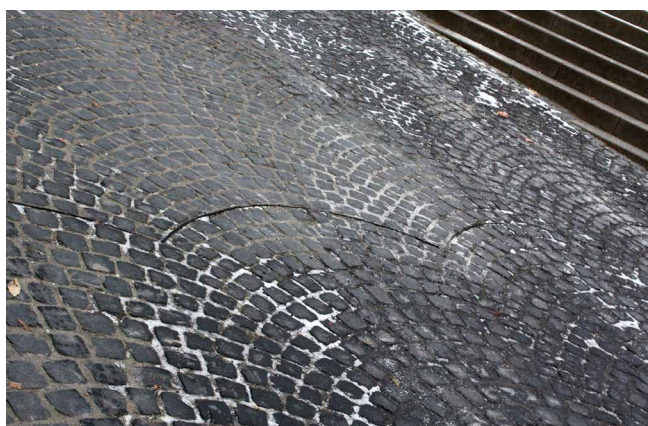
Abb. 9 a+b: Bewegungsfugen in einer in gebundener Bauweise erstellten Pflasterdecke
