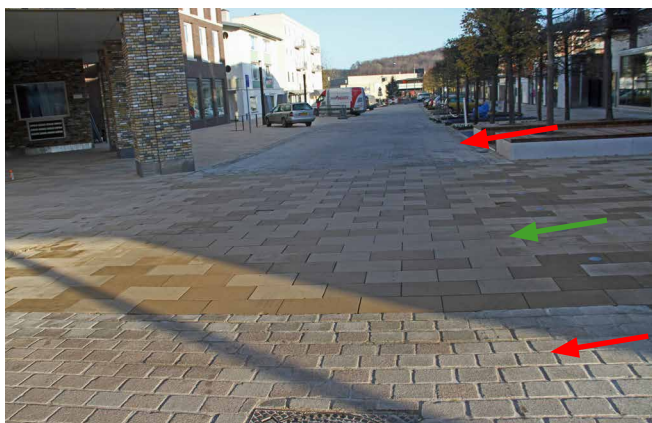
Abb. 7: Ungebundener Fußgängerüberweg über eine in vollgebundener Bauweise ausgeführte Straße
