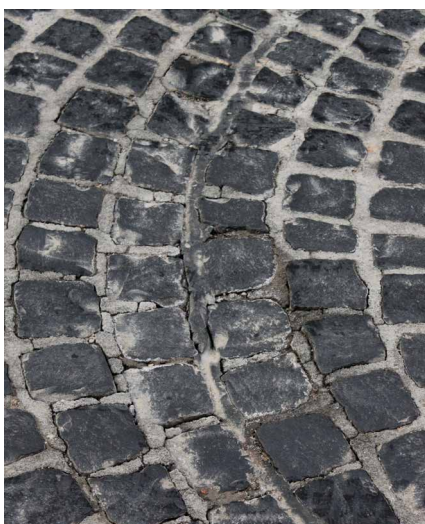
Abb. 9 a+b: Bewegungsfugen in einer in gebundener Bauweise erstellten Pflasterdecke
