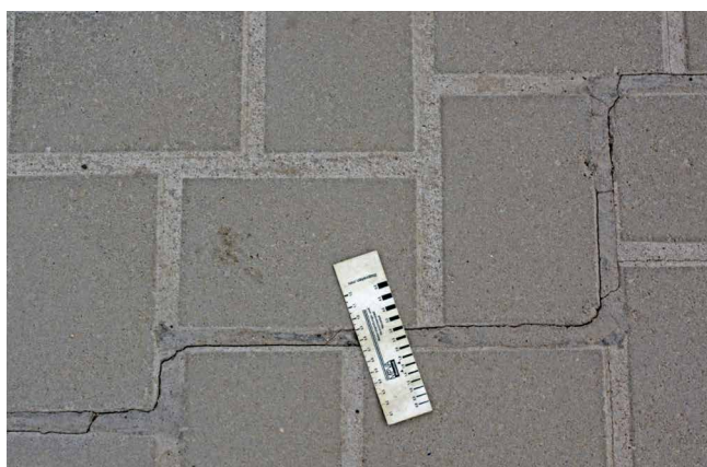
Abb. 4 a+b: Rissbildung in einer vollgebundenen Pflasterdecke
