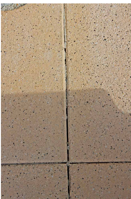
Abb. 6 a+b: Zerstörung des Fugenmörtels
