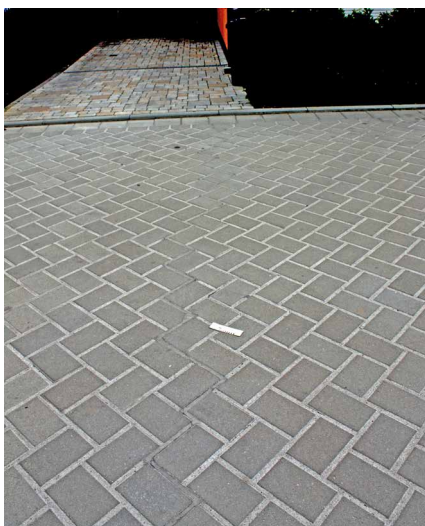
Abb. 4 a+b: Rissbildung in einer vollgebundenen Pflasterdecke
