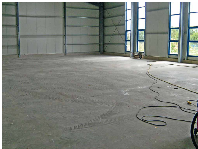
Abb. 3: Industrieboden des betreffenden Objektes
