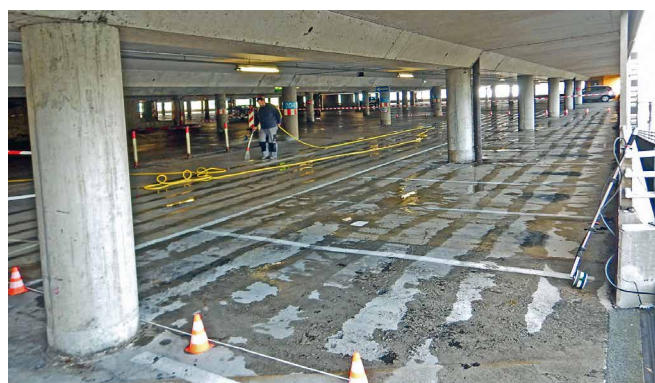
Abb. 5 a+b: Vorgehensweise bei der Potenzialfeldmessung
