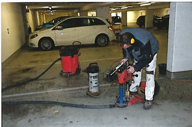
Abb. 3 a-c: Vorbohren mit Fixierung des Bohrständers
