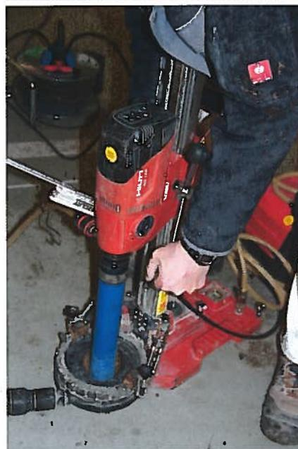
trockene Vorbohren unerwünschte thermische Spannungen in den Prüfbereich eingebracht werden, welche die zu ermittelnden Messwerte negativ beeinflussen.
