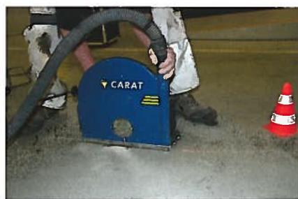
Abb. 2 a-c: Einschneiden mit einem Trockenschneider mit Absaugvorrichtung
