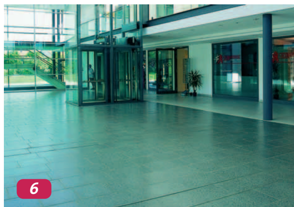
Eingangsbereich eines gewerblich genutzten Objekts, R 9 nach DIN 51 130.
