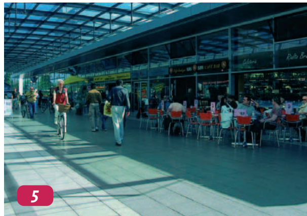
Überdachter Außenbereich eines Einkaufszentrums („Mall“), neuerdings (seit Ausgabe der GUV R-181 [1] vom Oktober 2003) R10 + V4 oder R11 nach DIN 51 130 – vorher meist SRT + Ausfluss nach FGSV Merkblatt [5].
